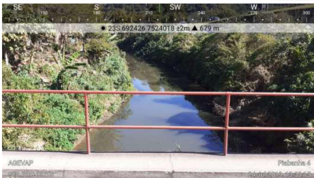
Figura 3.1-13: Visada para montante do Ponto 4.
