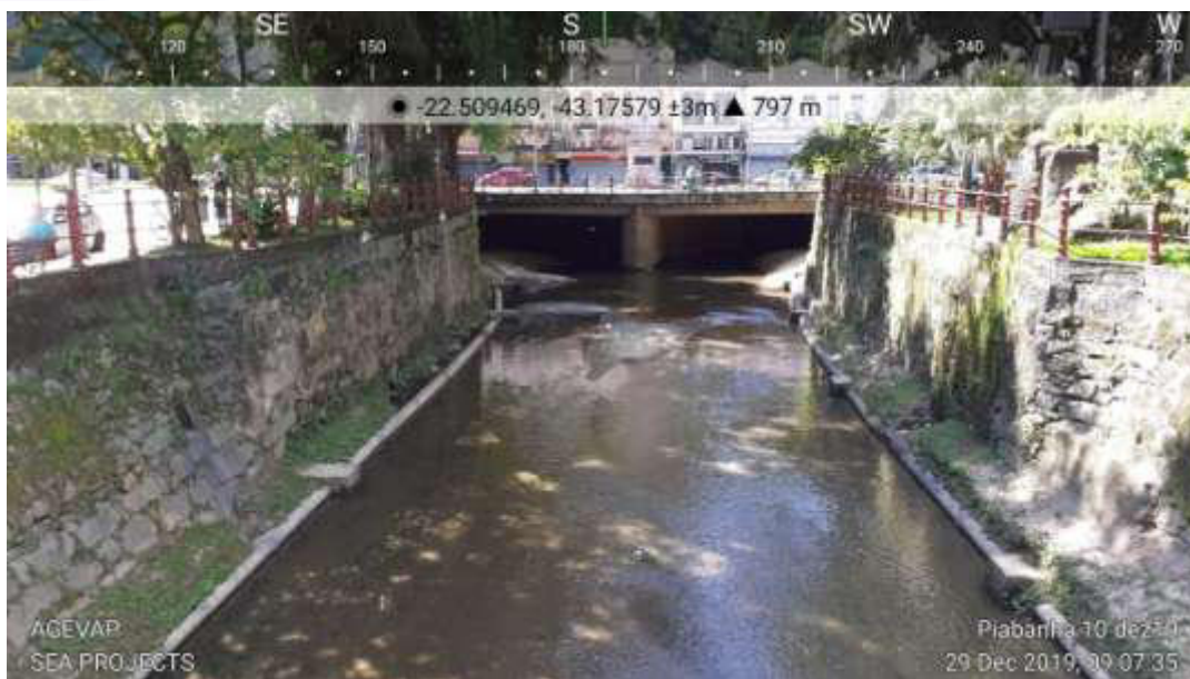
Figura 3.1-36: Visada para montante do Ponto 10.4.
