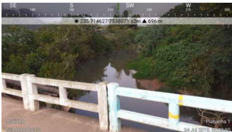
Figura 3.1-29: Visada para montante da estação controle – Ponto 9.
