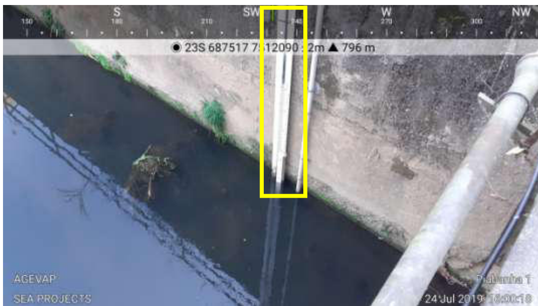
Figura 3.1-4: Régua de nível instalada no Ponto 1.
