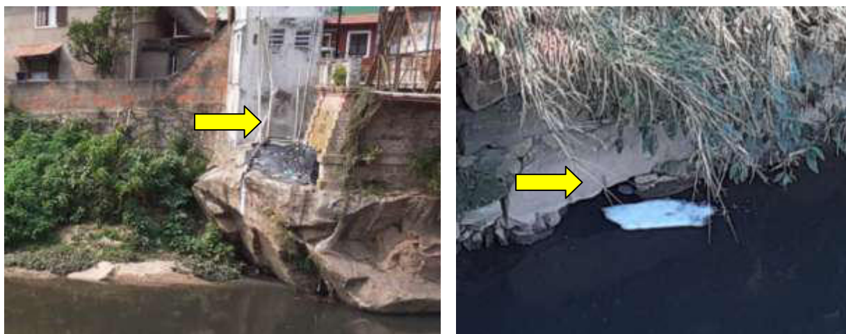
Figura 3.1-8 e 3.1-9: Visão da margem direita do Ponto 2, detalhes dos lançamentos de esgoto.
