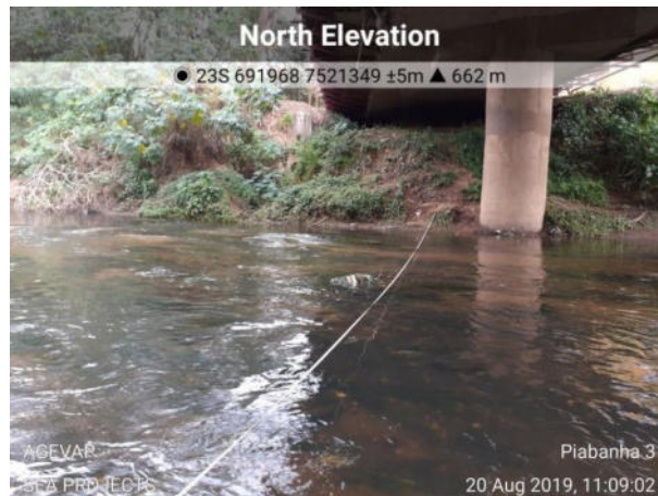
Ponto 3 – detalhe da trena
